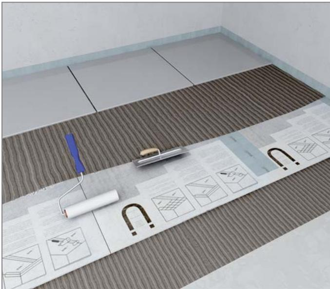
La natte de désolidarisation Subliner Flex & Dry permet de réduire les tensions entre les couches supérieures des carreaux céramiques ou de pierres naturelles. Elle permet un excellent pontage des fissures et convient parfaitement en rénovation, du fait de sa faible épaisseur.
