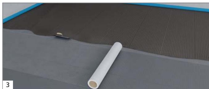
3 Armer avec la bande d'armature wedi Tools, noyée dans une colle à carrelage de type C2. Dans les pièces humides, l'étanchéification peut être réalisée alternativement à l'aide de la bande d'étanchéité wedi 610 ou wedi Tools.
