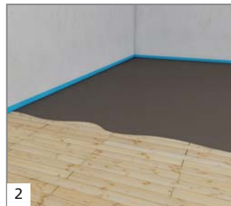
2 Appliquer de la colle à carrelage de type C2S1 ou C2S2 sur le support bois.
