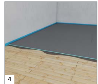
4 Poser le panneau de construction dans le lit de colle en décalant les joints.
