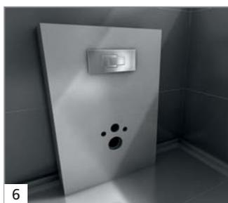
6 Le panneau d'habillage du bâti-support peut être carrelé directement après la pose de l'armature, sans traitement préalable. Réaliser des joints de fractionnement avec un mastic entre les revêtements au mur, au sol et aux angles.
