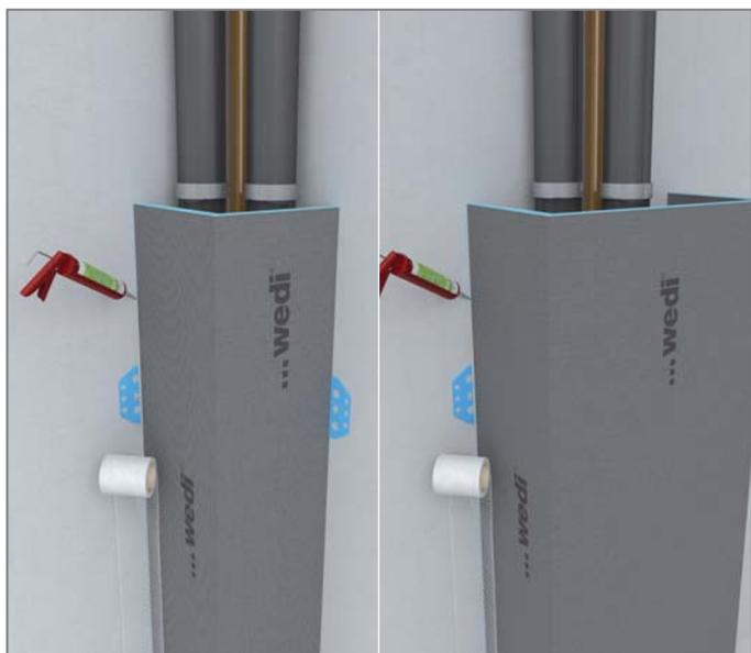
Grâce aux éléments en angle wedi Mensolo, l'habillage est effectué rapidement et proprement.
