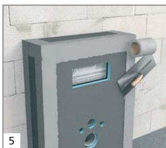
5 Traiter les joints et les raccords avec la bande d'armature wedi Tools.
